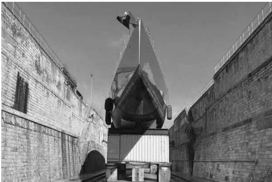
Deux gros chantiers démarrent en octobre et occuperont les formes de radoub du grand port maritime de La Rochelle.
